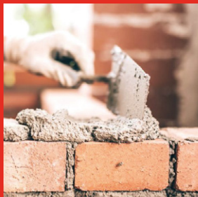
L'assemblage ou les joints
