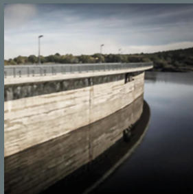
Barrage de la cuerda del pozo Soria, Espagne
