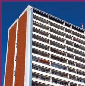
Bâtiment en Precast
