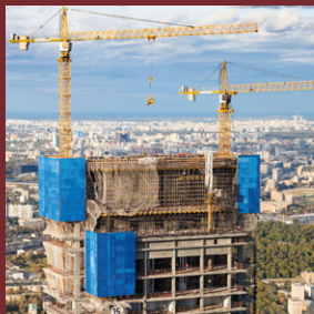
Travaux en hauteur
