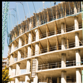
Les piliers de bâtiment
